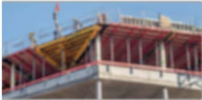
Um die große und stumpfschneidigen Ecken an den Deckenflächen des 2-flügeligen Bürobaus in Schichtenform zu betonen, hat Hühnemeier die technische Projektentwicklung Sonderbauteile entwickelt, die sich optimal mit dem Typensystem Deckenschalung kombinieren lassen.
